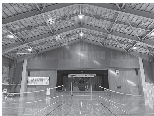
仁多中学校屋内運動場
